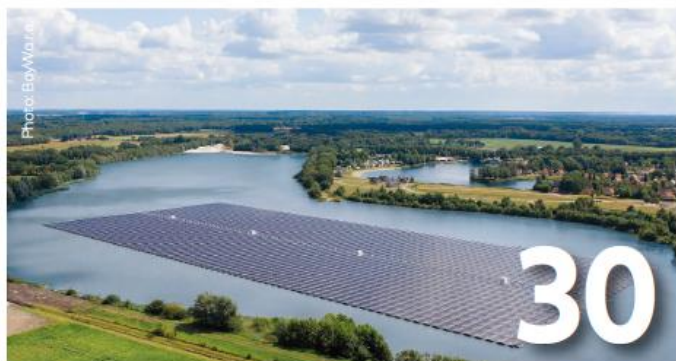
再生可能エネルギー分野期待の革新：「Floatovoltaics=フロートボルトイク」（浮体式太陽光発電）
