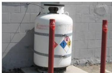
An der Wand befestigter Behälter für brennbare Flüssigkeiten
