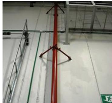
Sprinkler-Steigleitung mit Erdbebensicherung
