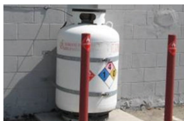
Tanque de líquido inflamable atado a la pared
