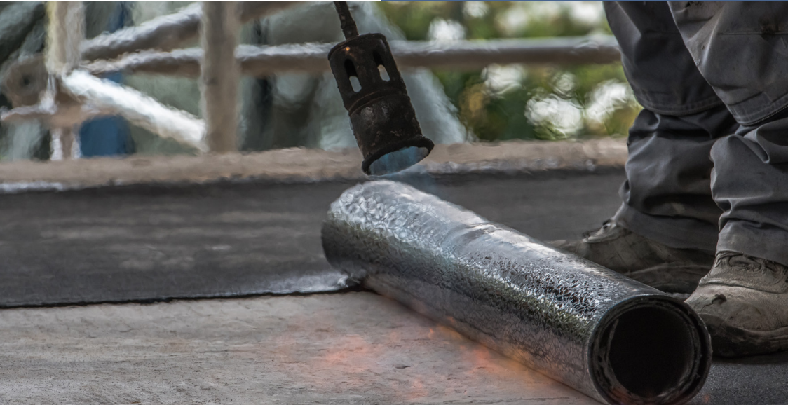
Dacharbeiten mit Gasflamme
