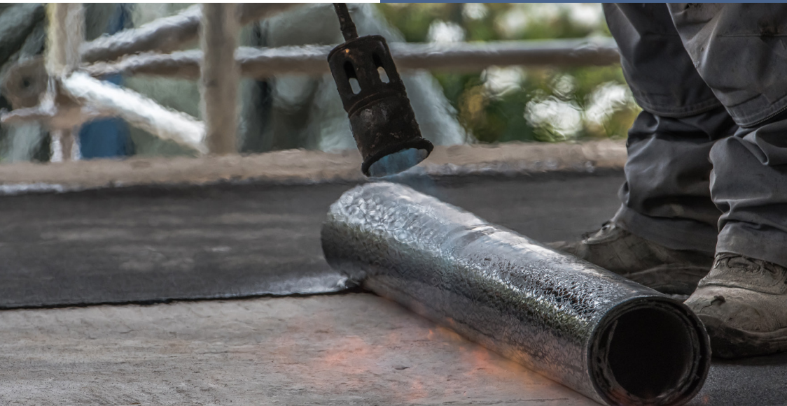
Travaux d'étanchéité sur toiture avec chalumeau
