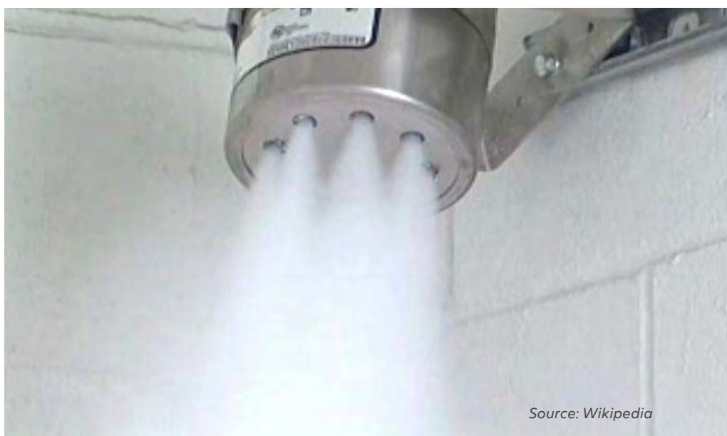
Emission d'un système d'extinction d'incendie à base d'aérosols de condensation.
