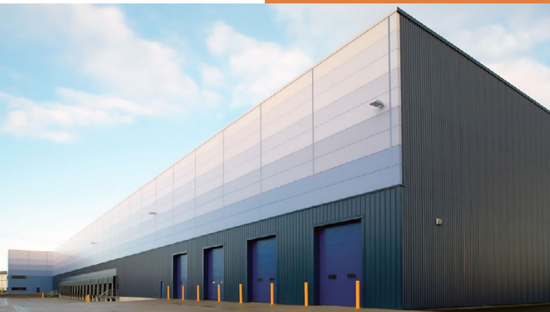
Edificio con pareti in pannelli sandwich in metallo coibentato (Fonte: Kingspan)
